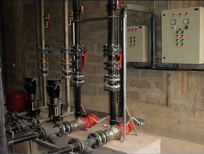
Armoires électrique BT / LT electric cupboards
